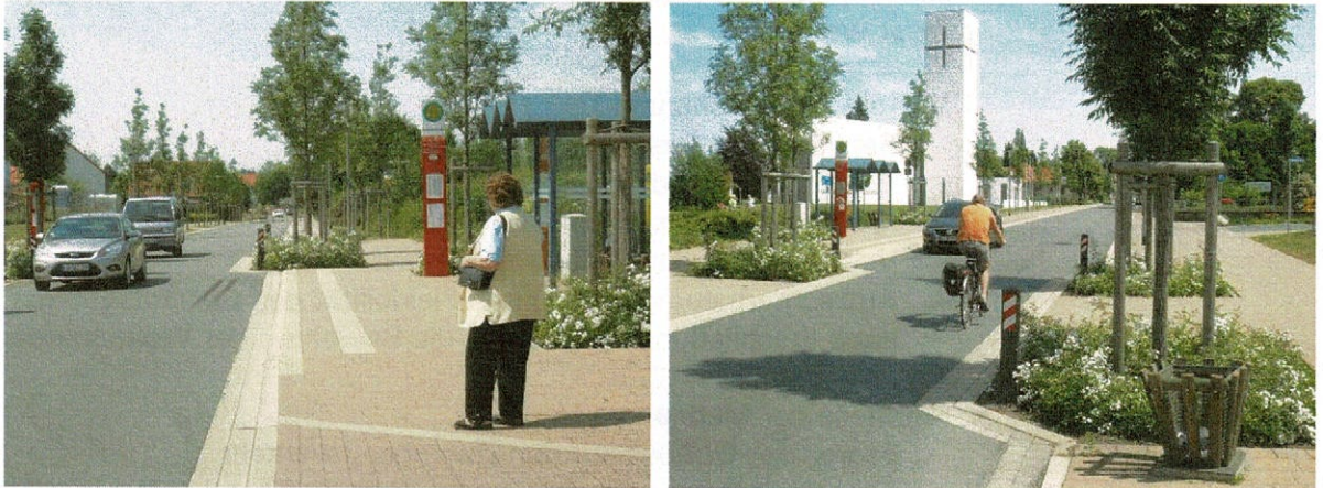
Abb. 20 Gestaltungsmöglichkeiten für Fahrbahneinengungen in Haltestellenbereichen (Leopoldshöhe)
