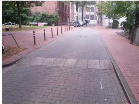
Teilaufpflasterung im Zuge von Rad- und Gehwegverbindungen (Hannover)
